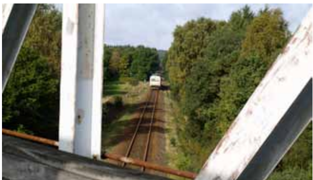
Banelinjen mellem Silkeborg og Herning - set fra broen.
